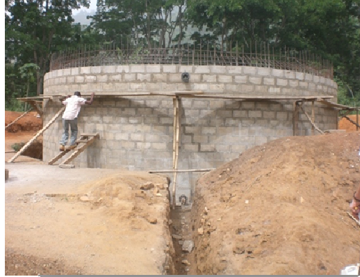
Réservoir d'eau en construction
